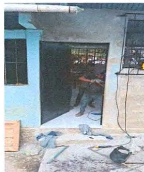
Foto 2: Instalación de una puerta para esta clase
