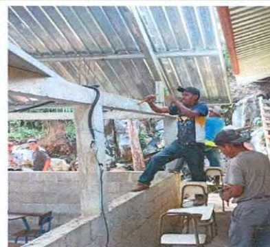
Foto 4: Instalación de láminas laterales en el aula nueva.
