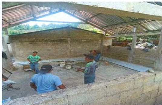
Foto 1: Colocación de piso cerámico en el aula nueva.
