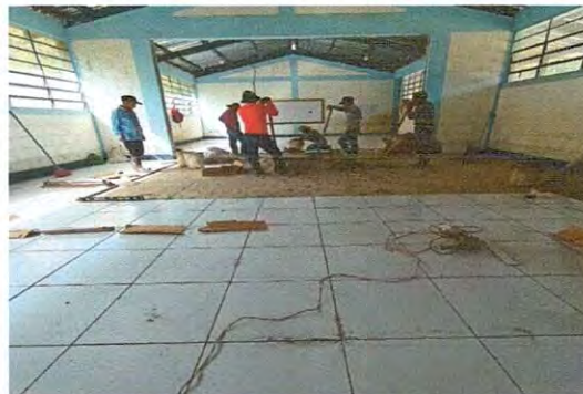
Foto 2: Colocación de piso cerámico en el aula de tercero y sexto primaria.
