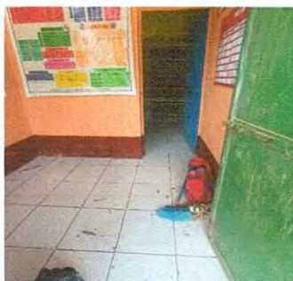
Foto 3: Colocación de piso cerámico en la dirección.
